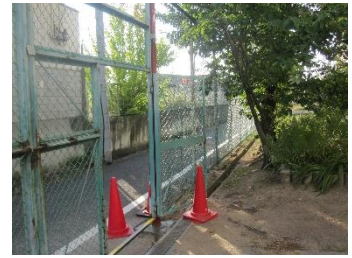
東ヶ丘ピロティの門、改修!
